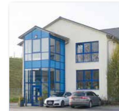
Abb.: Firmengebäude, Verwaltung und Werkstatt der ATS Gluck GmbH
